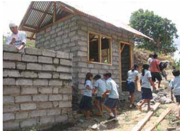
Anak Bunga berlari kembali ke kelas setelah melihat bangunan dapur dan toilet yang hampir selesai
